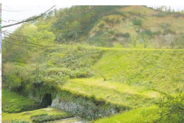
築立暗渠の場所
