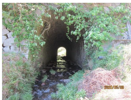
築立暗渠の内部
