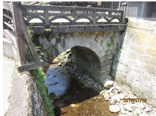
羅漢町石造アーチ橋
