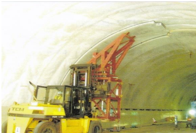
セグメントの施工
